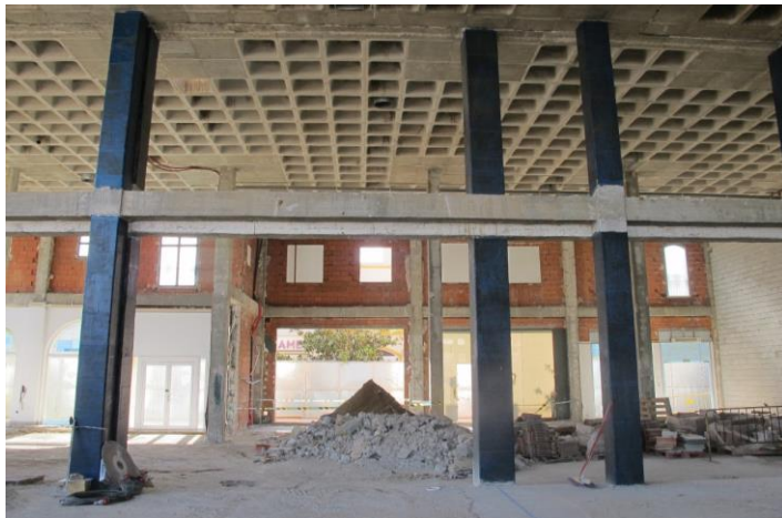
Refuerzo de vigas a momentos positivos con MasterBrace LAM, y de pilares a confinamiento MAsterBrace FIB 450/50.
