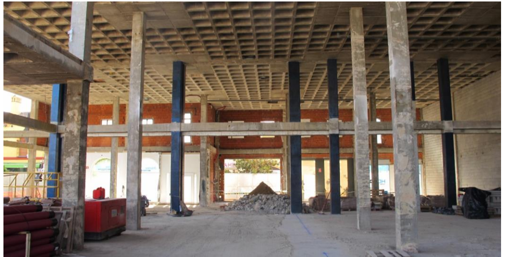
Refuerzo de vigas a momentos positivos con MasterBrace LAM, y de pilares a confinamiento MASTERBrace FIB 450/50.
