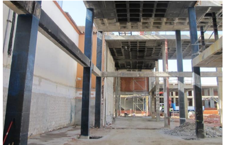
Refuerzo de vigas a momentos positivos con MasterBrace LAM, y de pilares a confinamiento MAsterBrace FIB 450/50.
