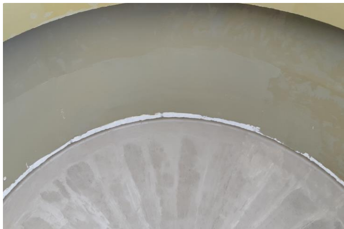
Protección química de decantadores de depuradora con Sistema MasterSeal 7000 CR.
