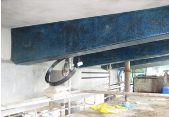
Refuerzo mediante laminados y hojas de fibra de carbono Sistema MasterBrace
