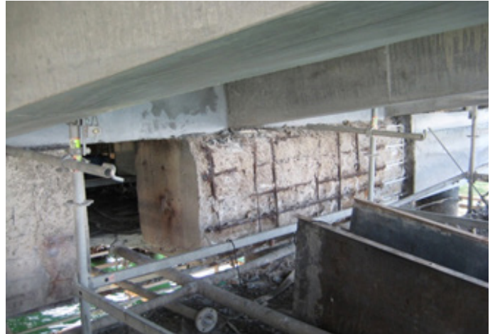
Reparación estructural con gama MasterEmaco
