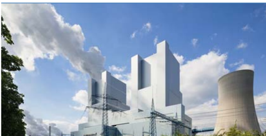
Torre de refrigeración
