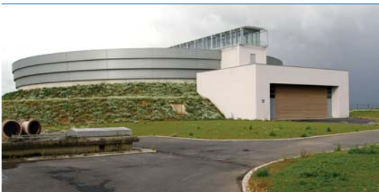
Depósito para agua potable
