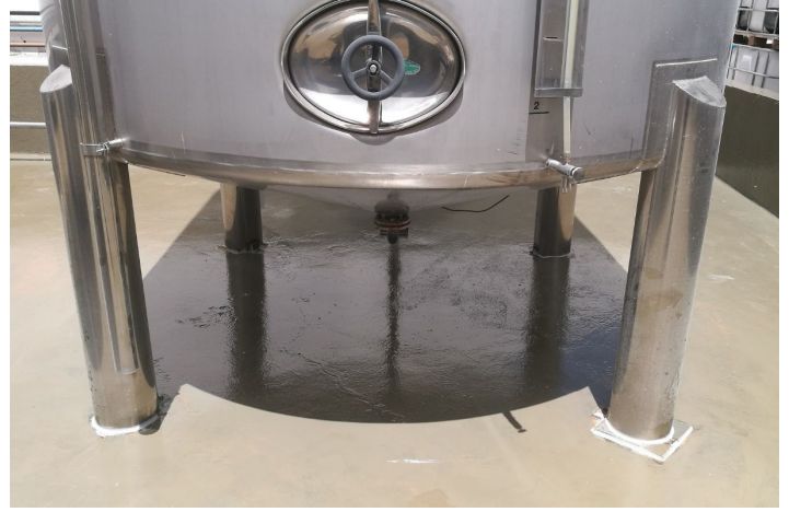
Impermeabilización de cubetos de retención con Sistema MasterSeal 7000 CR.
