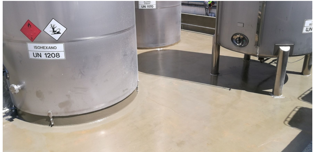
Impermeabilización de cubetos de retención con Sistema MasterSeal 7000 CR.
