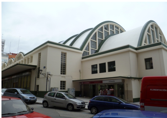
Cubiertas Principales y Laterales
