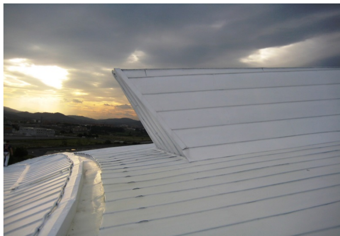
Detalle de impermeabilización finalizada
