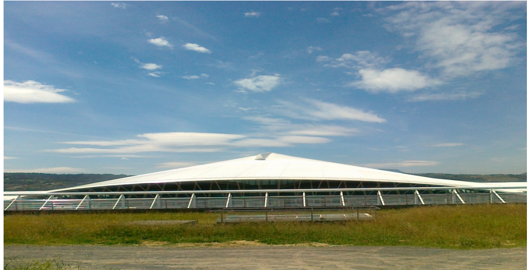
Vista de la cubierta impermeabilizada
