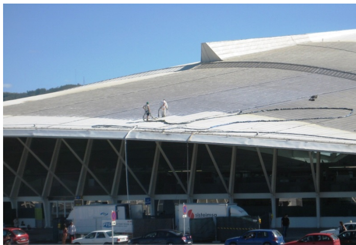
Impermeabilización mediante proyección de membrana MasterSeal M 803
