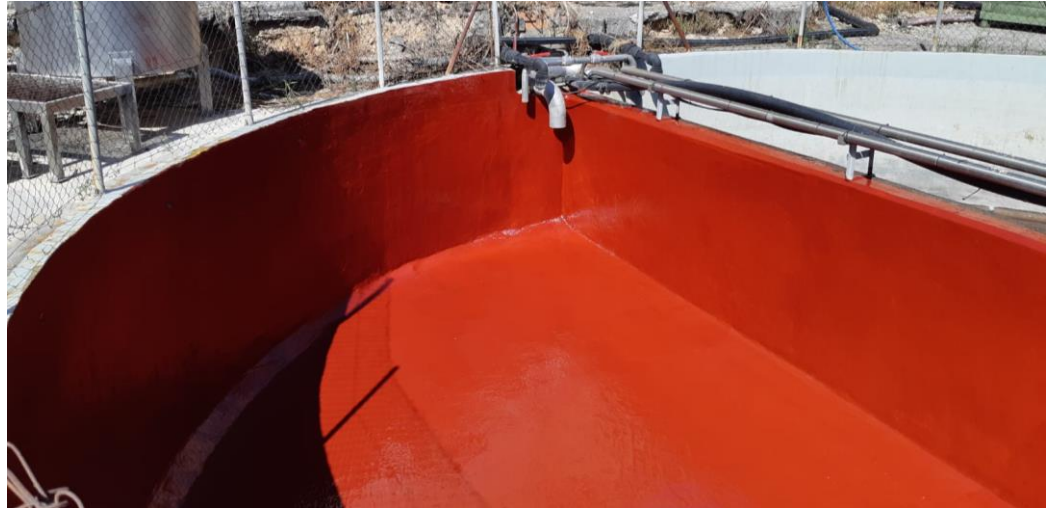
Impermeabilización de depósitos en depuradora con Sistema MasterSeal 7000 CR.
