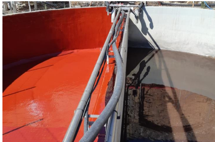
Impermeabilización de depósitos de depuradora con Sistema MasterSeal 7000 CR.
