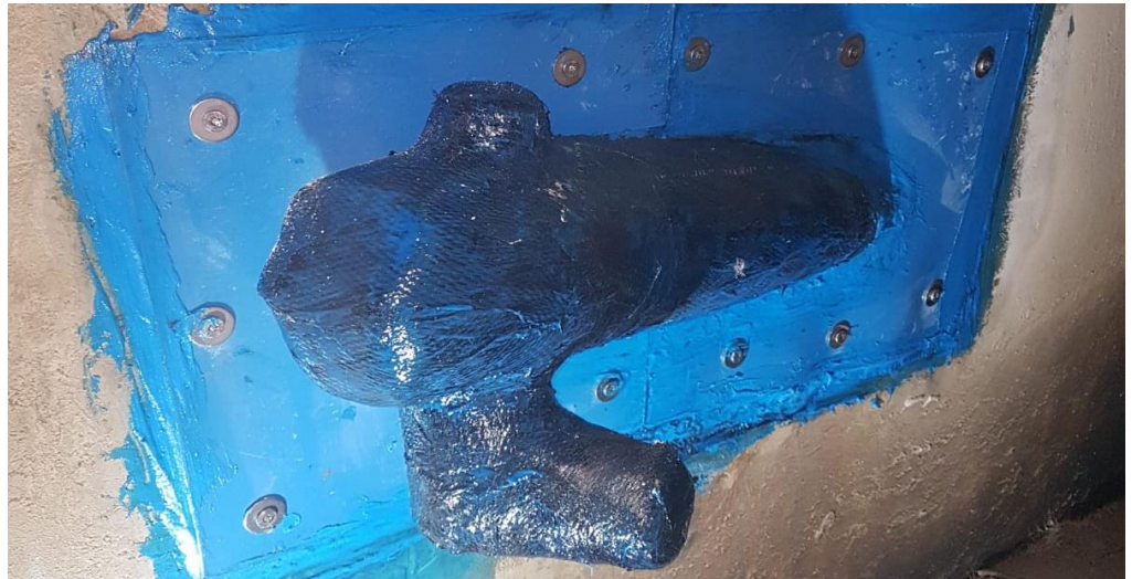
Estado final de las tuberías encapsuladas con MasterBrace y fijadas mecánicamente al soporte de hormigón.
