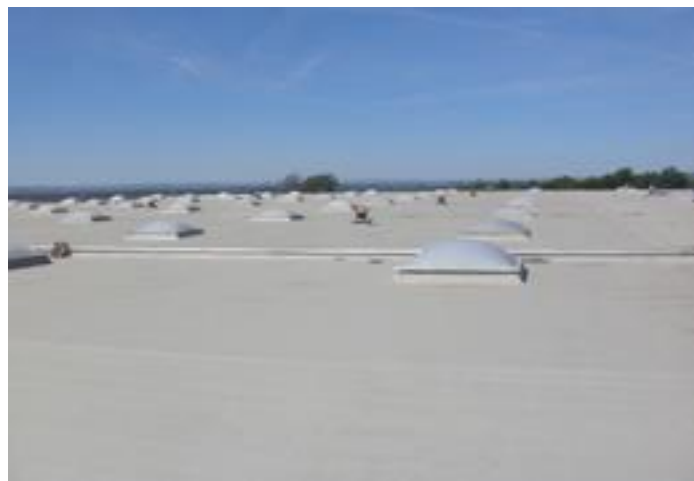
Proyección de membrana impermeable dentro del sistema MasterSeal Roof 2103, y acabado final de la cubierta.
