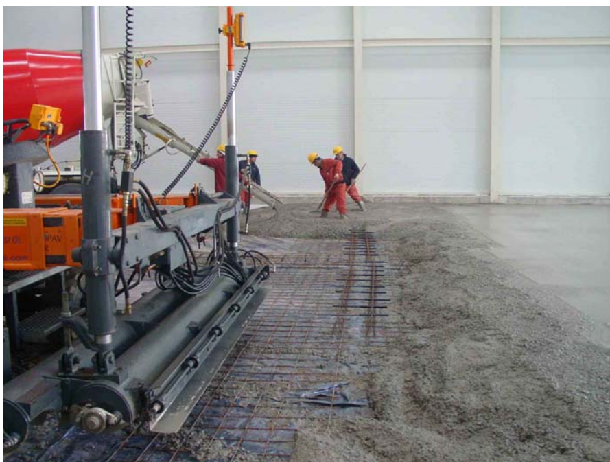
Realización de los recrecidos con hormigón de retracción compensada
