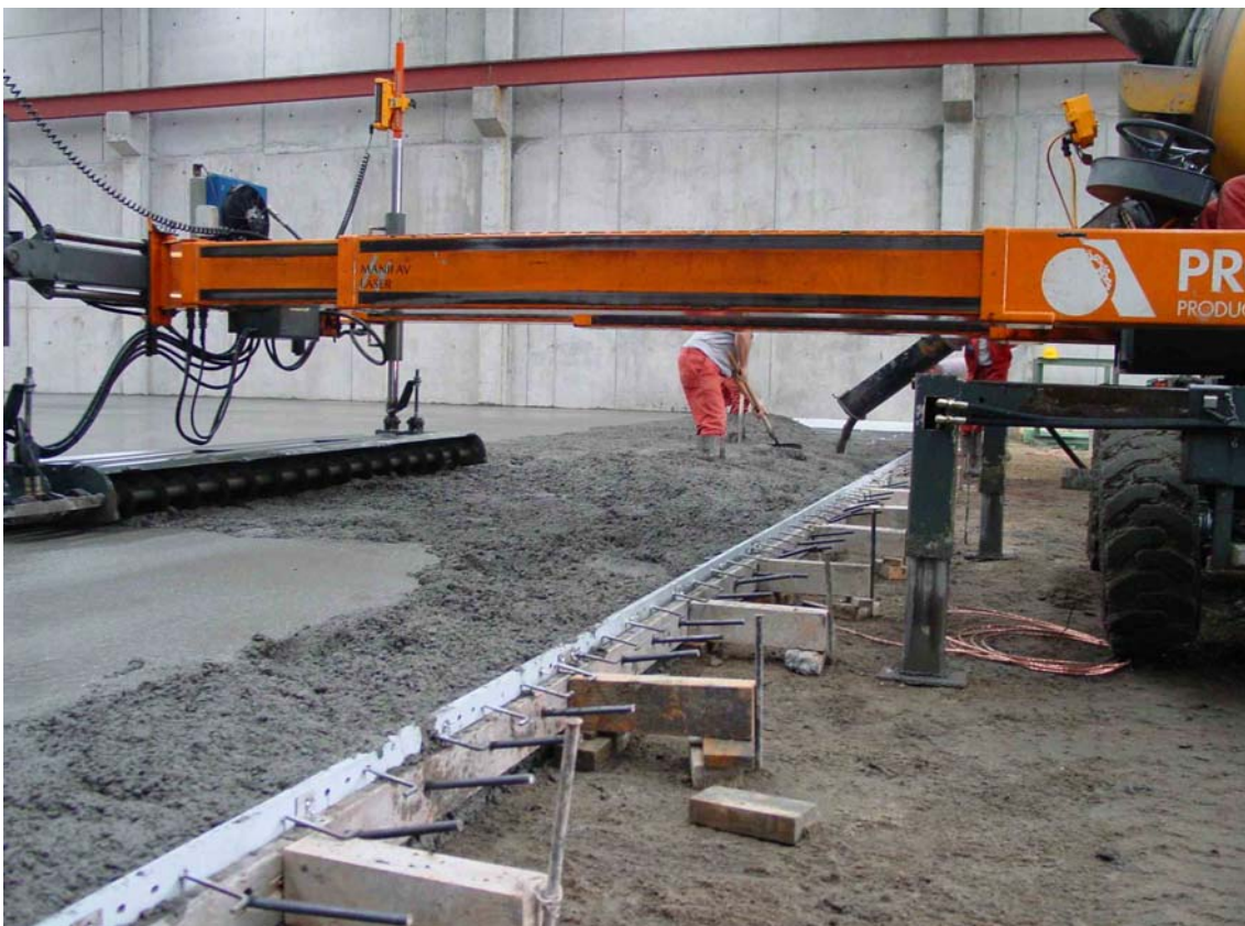
Puesta en obra del hormigón con aditivo reductor de retracción RHEOCURE SFR-2
