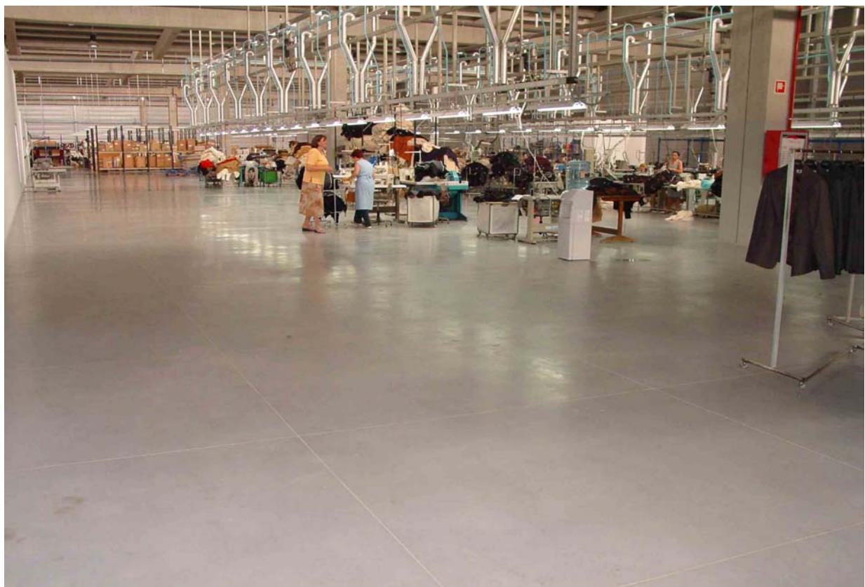
Aspecto del pavimento terminado y en servicio
