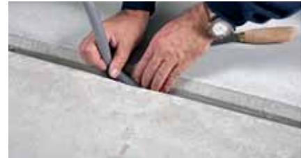
Colocar el fondo de junta con el diámetro adecuado para que quede perfectamente sujeto y asegurando que no se mueva al aplicar la masilla.
