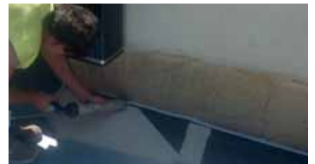
Aplicar la masilla MasterSeal NP 472/474 de forma continua evitando la inclusión de burbujas de aire.
