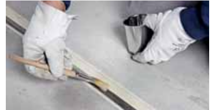
Aplicar la imprimación en los labios de la junta evitando impregnar el fondo de junta.
