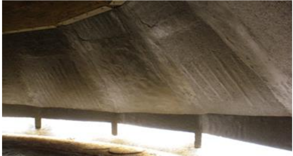
Protección del interior del decantador primario con poliuretano elástico MasterSeal M 808.
