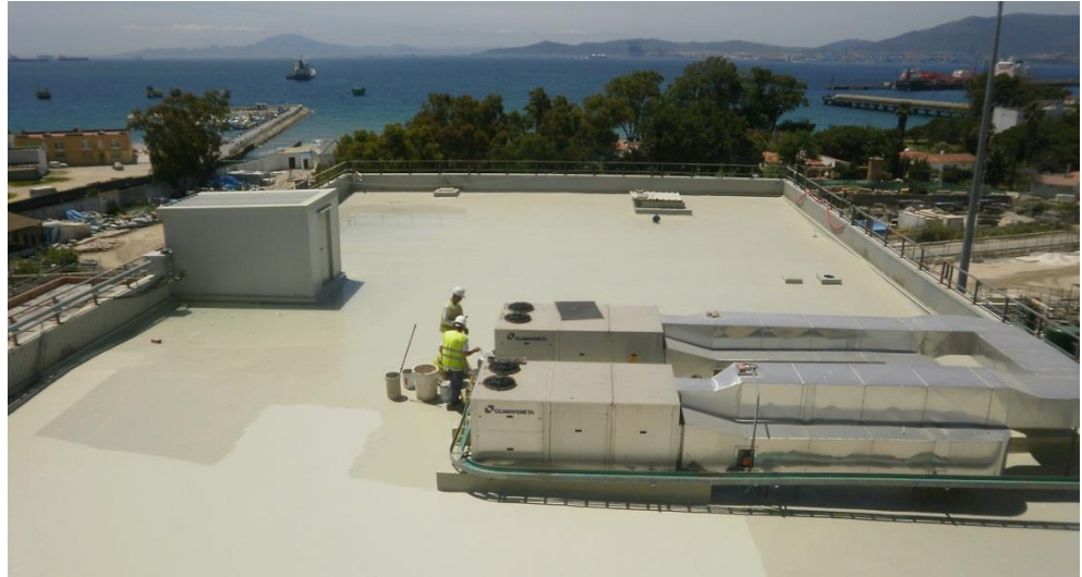
Cubierta impermeabilizada con poliurea MasterSeal M 689.
