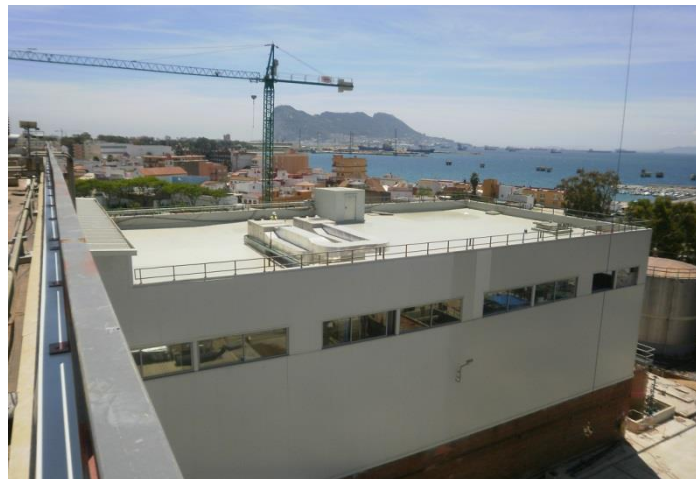
Trabajos de proyección y cubierta impermeabilizada.
