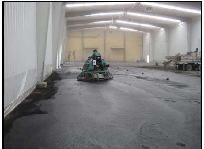
Pasada de máquina fratasadora
