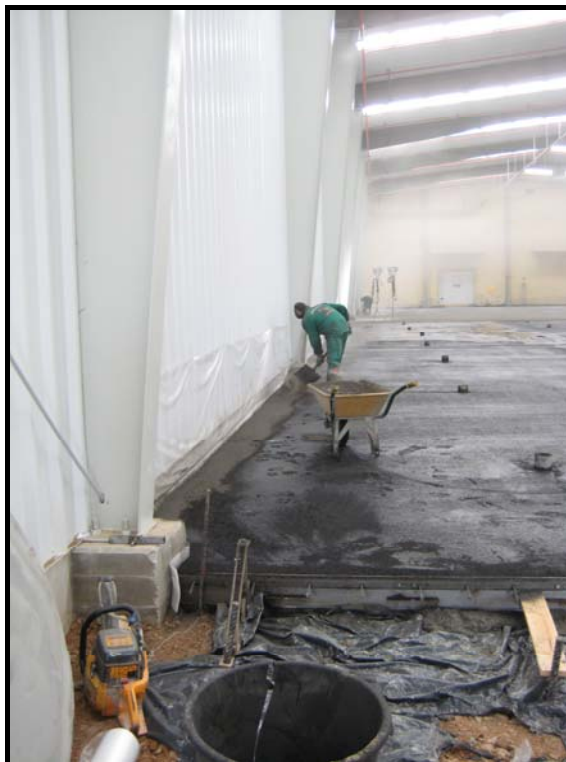
Dosificación extra en puntos singulares
