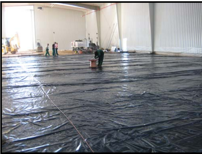
Colocación de cable trenzado de cobre
