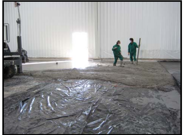
Extendido del hormigón
