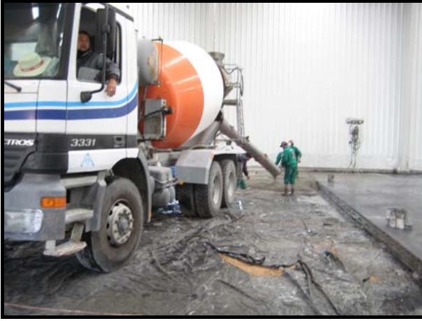
Vertido de hormigón
