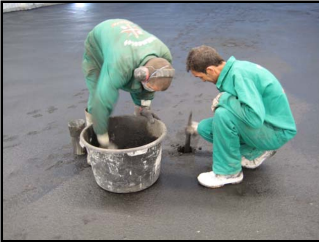
Relleno de huecos de los tubos de PVC de las espirales
