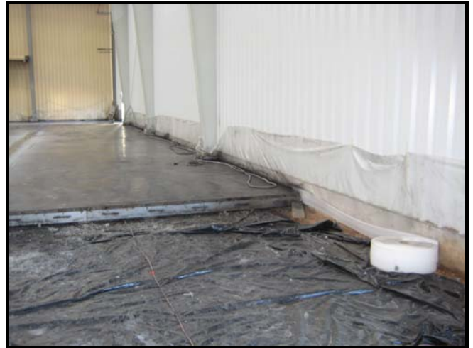
Colocación de FONPEX en perímetro
