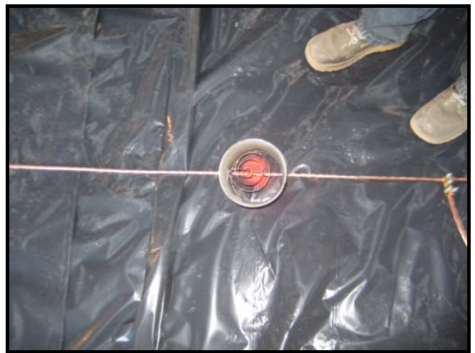
Protección de espirales con tubo de PVC
