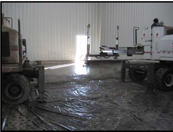
Nivelación de hormigón mediante máquina LÁSER SCREED.
