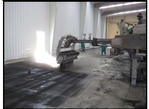
Aplicación de una 1ª dosificación del MASTERTOP 201, mediante MÁQUINA ESPOLVREADORA.
