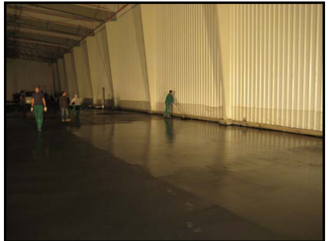
Aplicación de MASTERKURE 620
