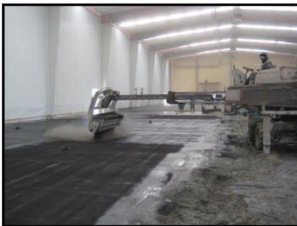
Aplicación de la cantidad restante del MASTERTOP 201, mediante MÁQUINA ESPOLVREADORA, alcanzándose los 9 kg/m2 finales.
