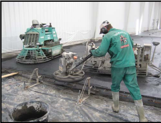
Fratado manual de bordes y esquinas
