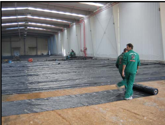
Colocación de de lámina de polietileno
