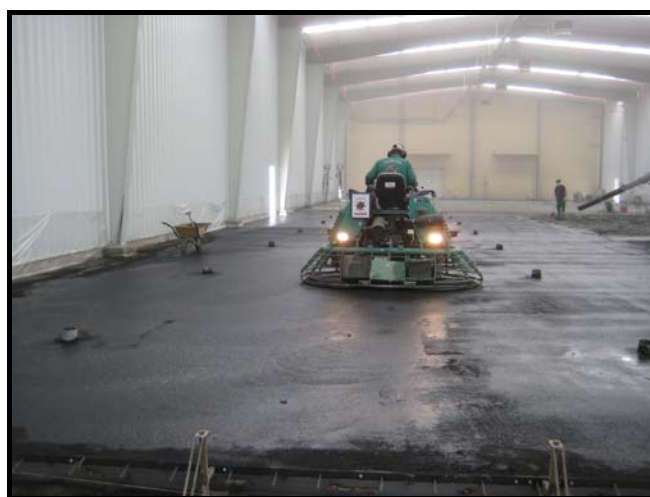
Pasadas de máquina fratasadora
