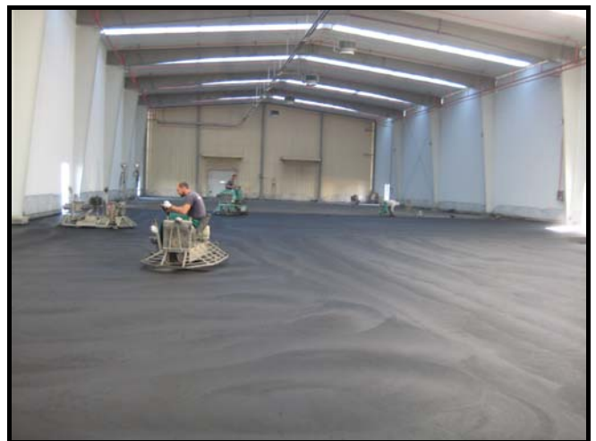
Pasadas sucesivas de fratasadora hasta obtener un acabado con la textura deseada
