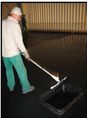
Aplicación de MASTERKURE 620
