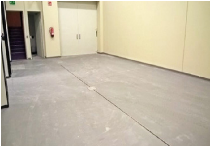
Muelle de Expedición Planta Sótano, Sistema Ucrete DP 10 en 4 mm.
