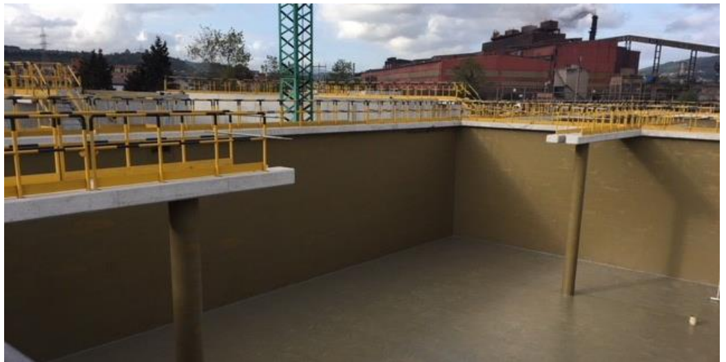
Protección química de cubetos de hormigón armado de con Sistema MasterSeal 7000 CR.
