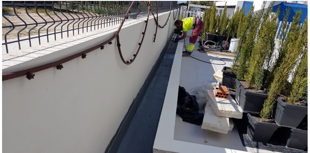
Impermeabilización de jardineras de difícil acceso con poliurea en cartuchos proyectada en frío MasterSeal M 811 KD
