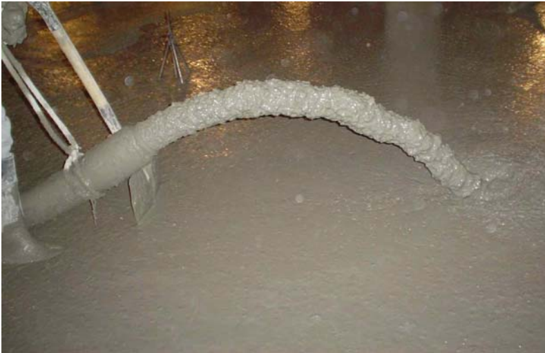
Aspecto del HAC. Elevada fluidez sin segregación ni exudación
