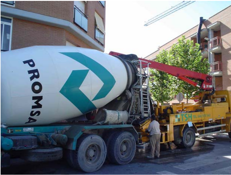
Aplicación por bombeo del HAC
