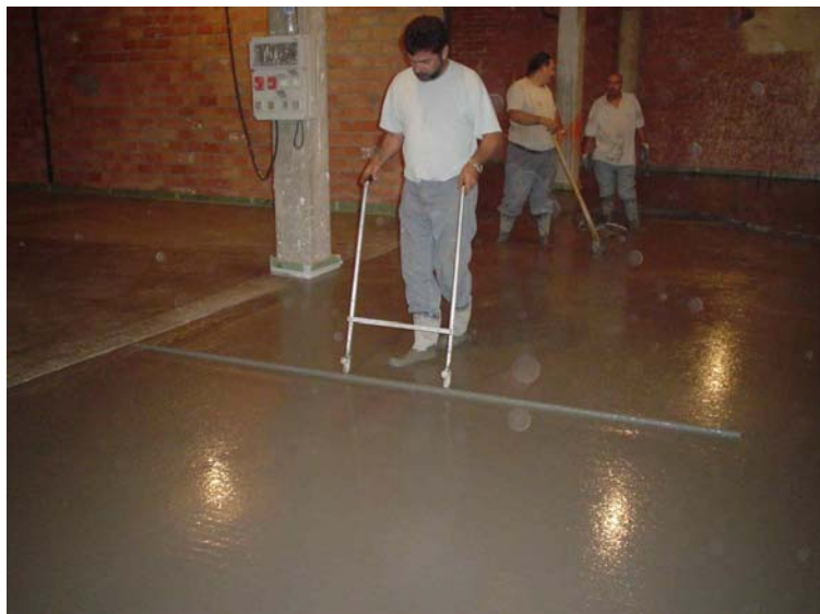
Alisado superficial del pavimento con HAC
