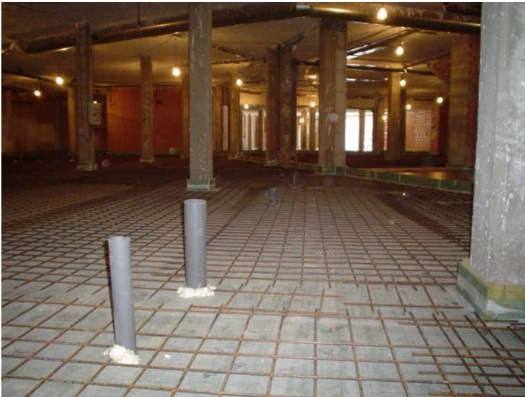
Vista de los pavimentos a hormigonar con HAC
