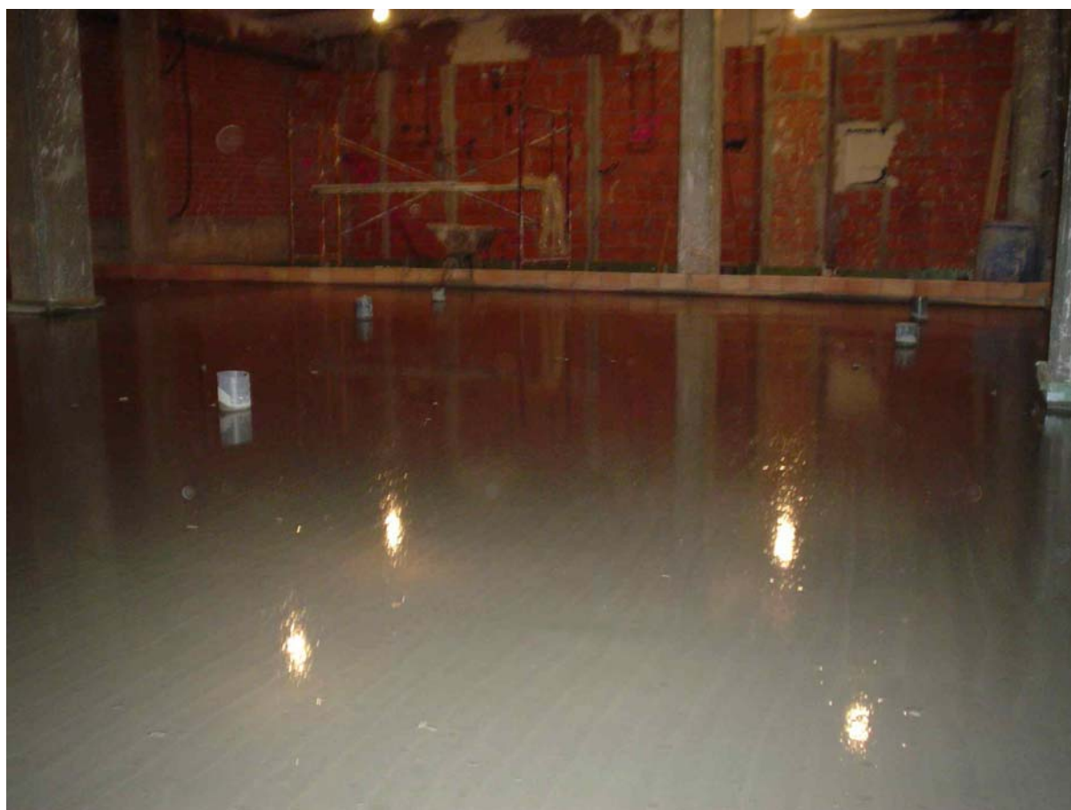
Aspecto de la superficie del pavimento ejecutado con HAC
