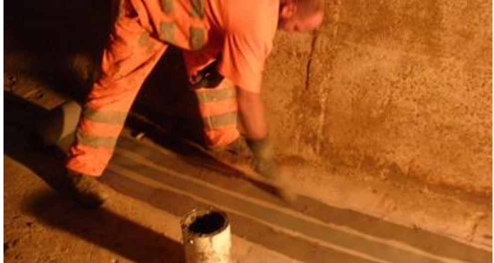
Sellado de junta con banda elástica MasterSeal 930
