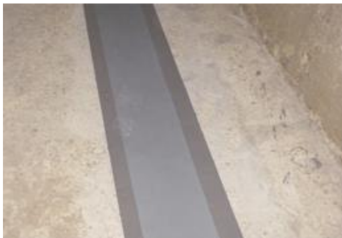
Colocación banda y aspecto de banda MasterSeal 930 terminada.
