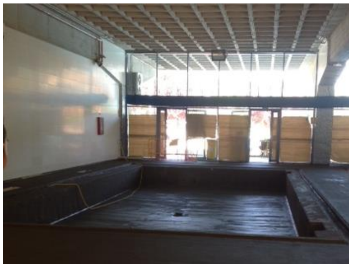
1. Piscina Cubierta del Polideportivo La Mina recién impermeabilizada con BASF 2. Sacos MasterSeal 550- Membrana Cementosa Flexible para la impermeabilización
