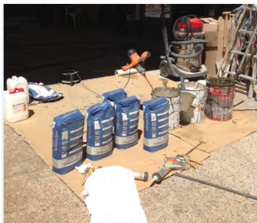
1. Piscina Cubierta del Polideportivo La Mina recién impermeabilizada con BASF 2. Sacos MasterSeal 550- Membrana Cementosa Flexible para la impermeabilización
