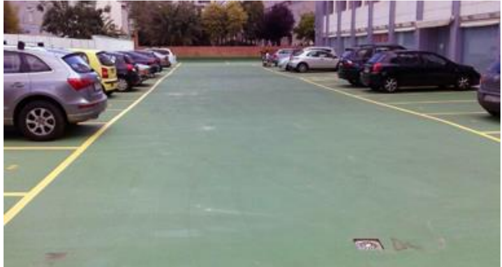
Parte de los 1800 m 2 de cubierta impermeabilizados con el Sistema MasterSeal Traffic 2201.
