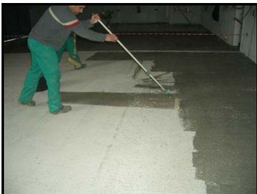
Imprimación del soporte
