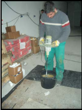
Mezcla de la imprimación
