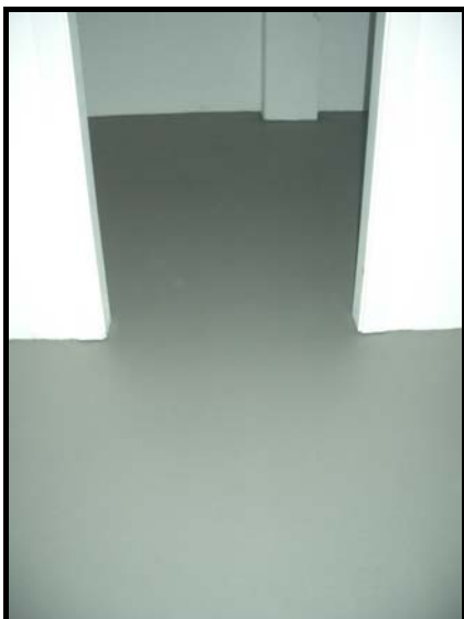
Acabado de cámara interior.
