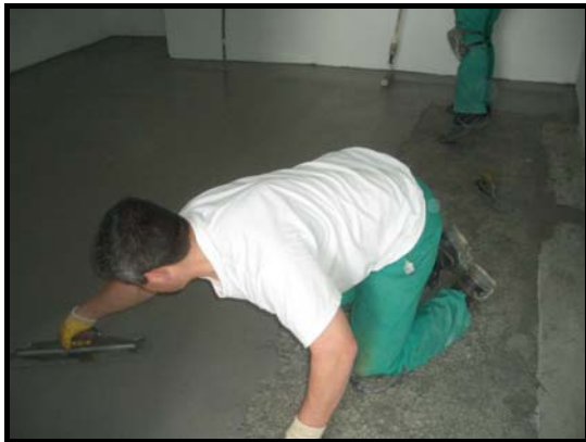
Aplicación del UCRETE UD 200 a llana en cámaras interiores.
