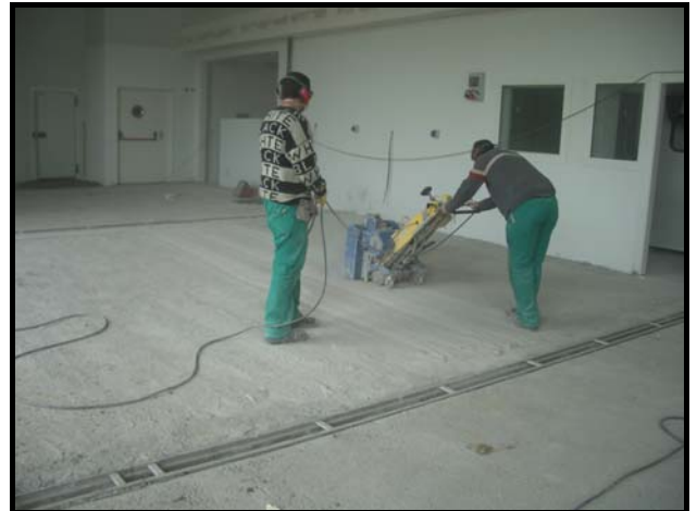
Preparación del soporte mediante fresado
