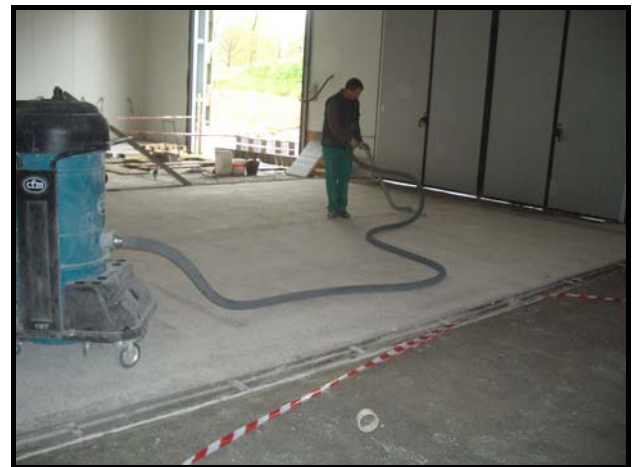
Limpieza (por aspiración) del soporte previa a la imprimación
