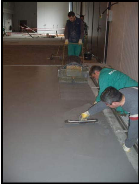
Aplicación del UCRETE UD 200 mediante "Screed Box" y llana.
