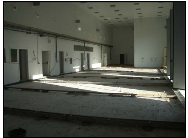
Estado previo al hormigonado
