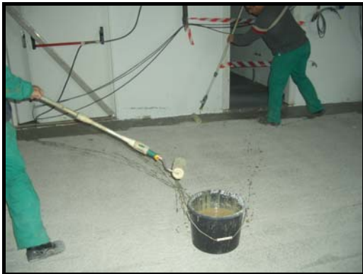
Imprimación del soporte
